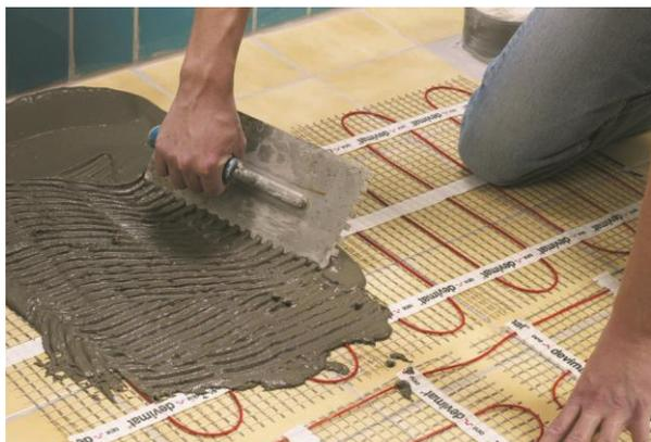
а – раскрой сетки нагревательного мата; б – поворот мата на 90 градусов; в – фиксация нагревательного мата к основанию с помощью клеевых полос на его сетке; г – нанесение промежуточного слоя плиточного клея
