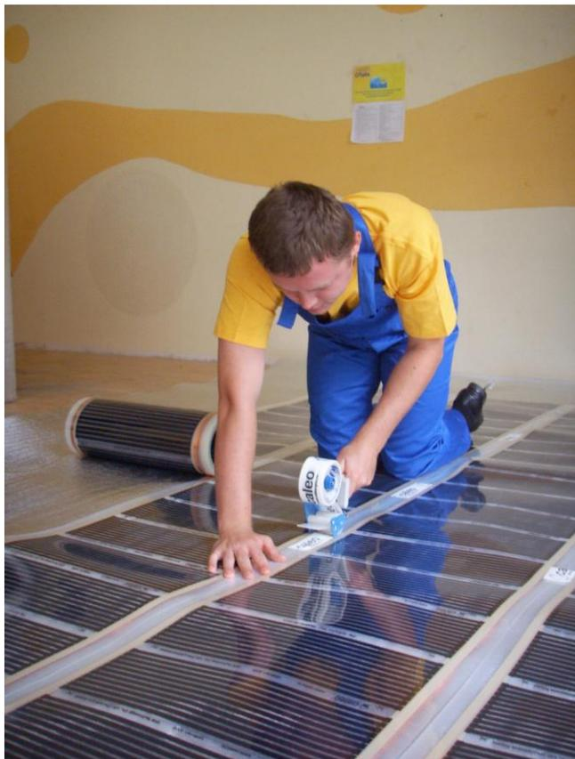
*а* – раскрой нагревательной пленки; *б* – установка контактных зажимов; *в* – установка битумной изоляции; *г* – выполнение углублений в теплоизоляционном слое в местах установки на нагревательную пленку контактных зажимов; *д* – фиксация полос нагревательной пленки с помощью скотча
